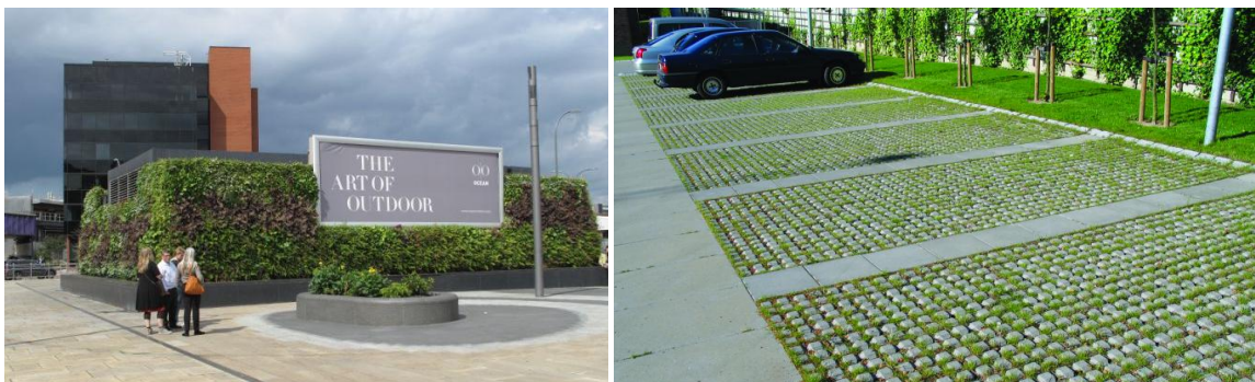
Figur 14-4. Tv. ses en grøn facade. Th. ses et eksempel på en permeabel belægning på p-plads.
