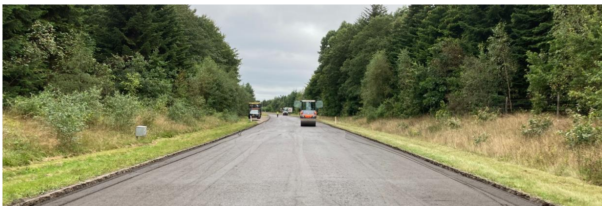
Fig. 4.7: Vue af belægning under afsluttende tromling, set i retning mod vest (Løgstørvej).
