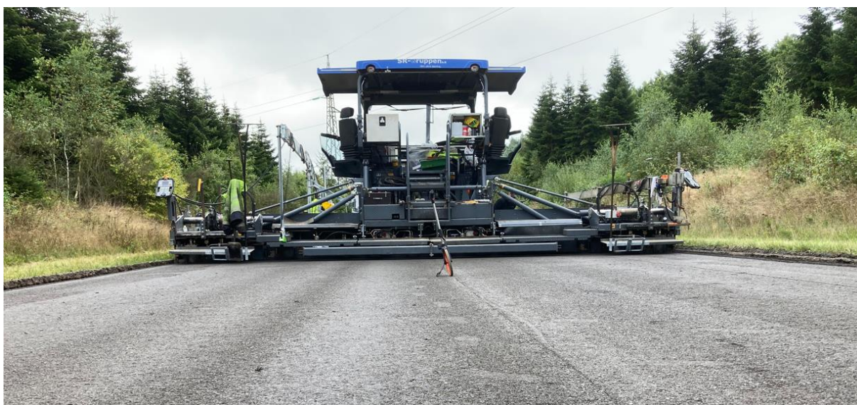
Fig. 4.4: Udlægning af BSM i 8,5 m bredde med højkomprimeringsstrygejern.
