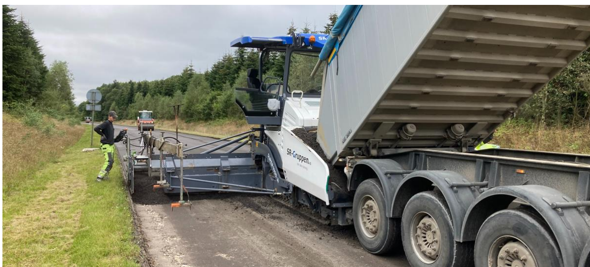
Fig. 4.3: Udlægning af BSM i fuld bredde efter affræsning af al gammel asfalt.
