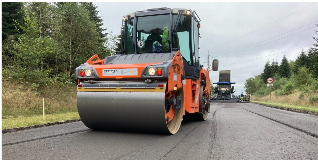
Fig. 4.5: Effektiv komprimering af BSM med tung oscillerende tromle.
