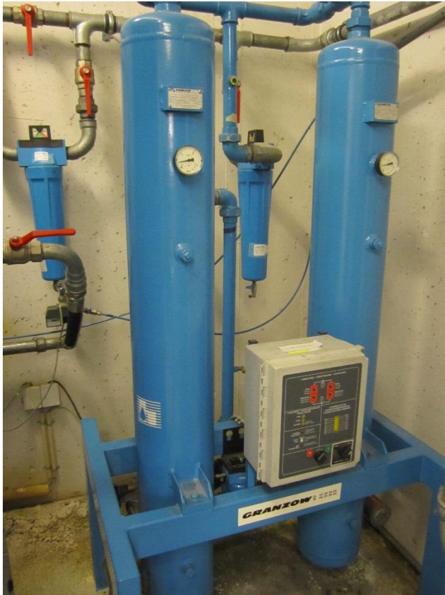
Figur 3.5.14 Adsorptionstørrer
