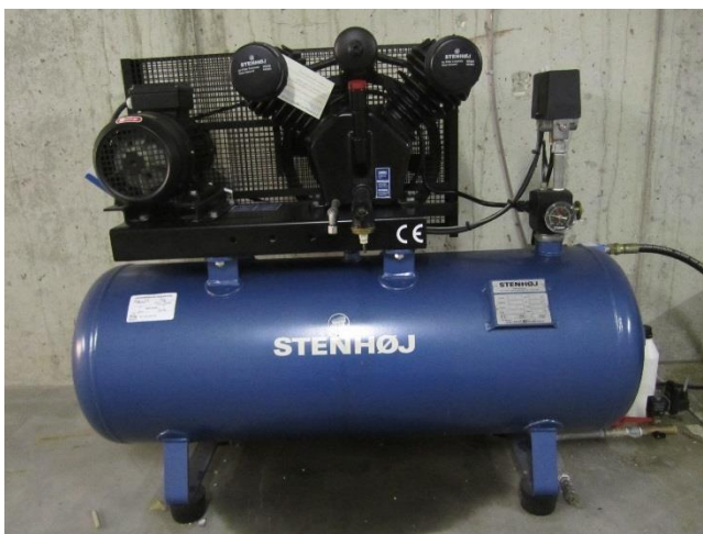
Figur 3.5.1 Stempelkompressor
