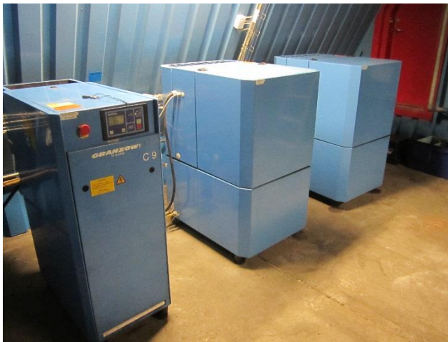
Figur 3.5.2 Skruekompressorer
