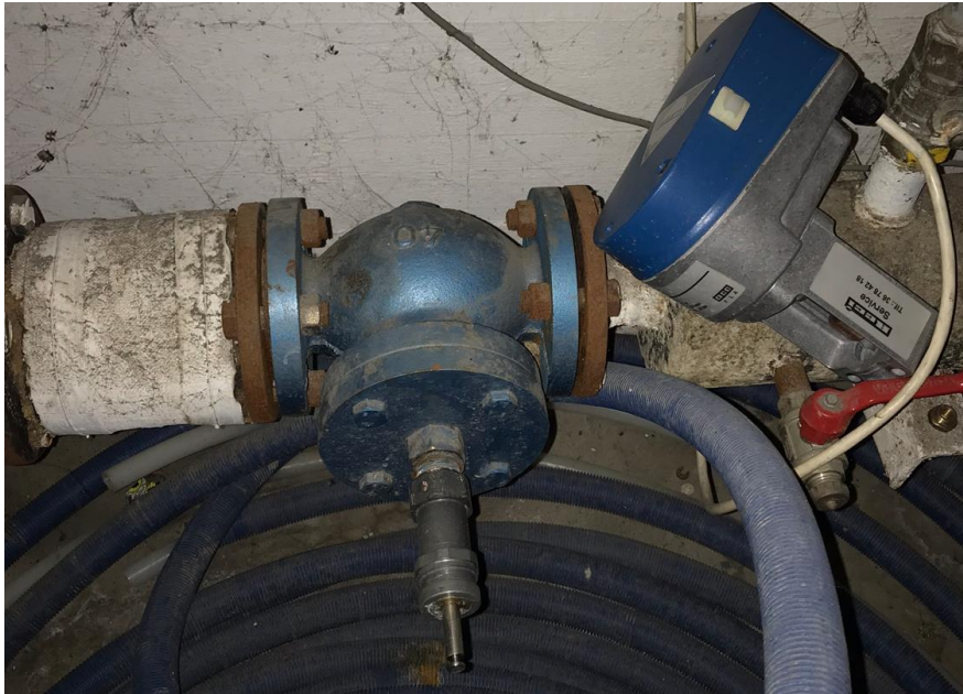
Motor pillet af motorventil.
