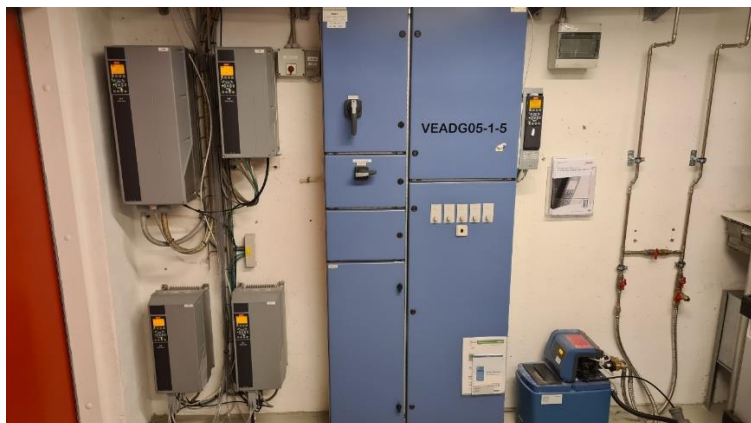
Figur 11.1.1.3 Frekvensomformer til regulering af omdrejningstallet.
